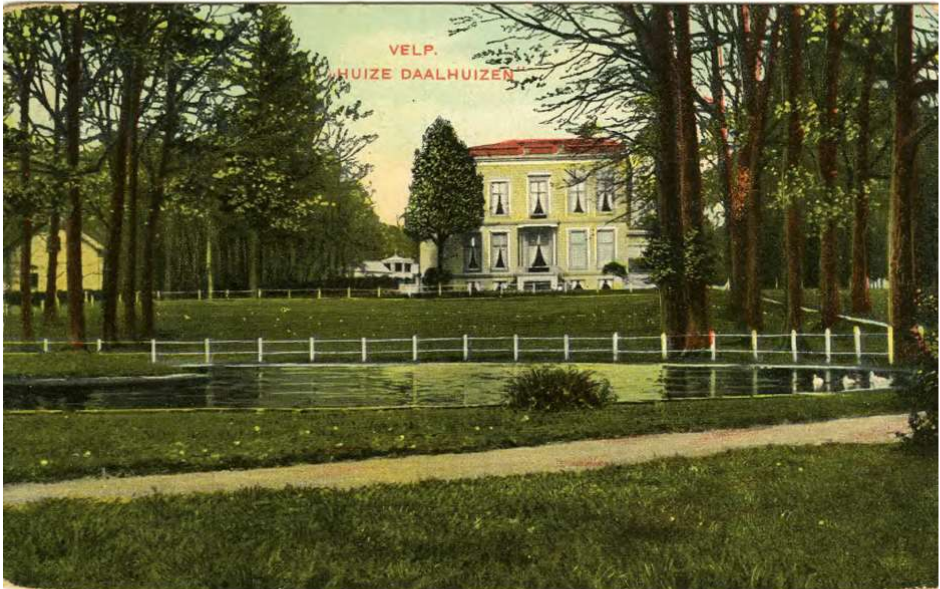
Daalhuizen in 1908, Gelders Archief nr. 1514-322. Links achter het huis is een deel van de orangerie zichtbaar; helemaal links een deel van het koetshuis.
